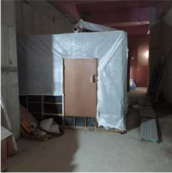
신내동 씨티건설-원일이엔지현장 배정된 컨테이너가 없어서, 현장 안에 직접 거꾸집으로 휴게실 만들.
