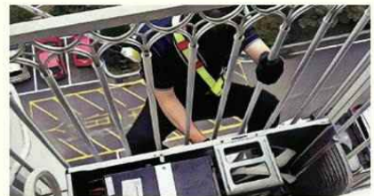
삼성 에어컨 설치수리 작업현장
