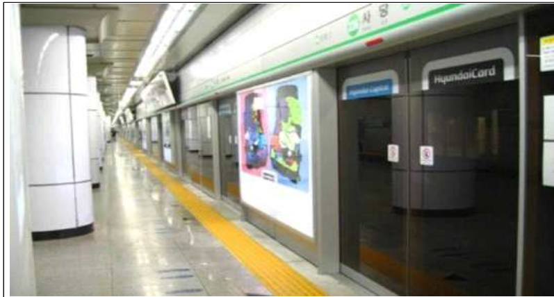
<그림 5> 2개의 고정문 위에 설치된 광고판 (2호선 사당역)
