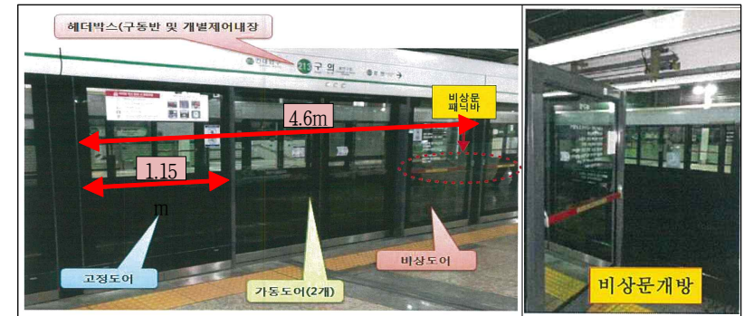
<그림 3> 구의역의 승강장안전문 1개 세트 및 비상문 개방 시의 모습
