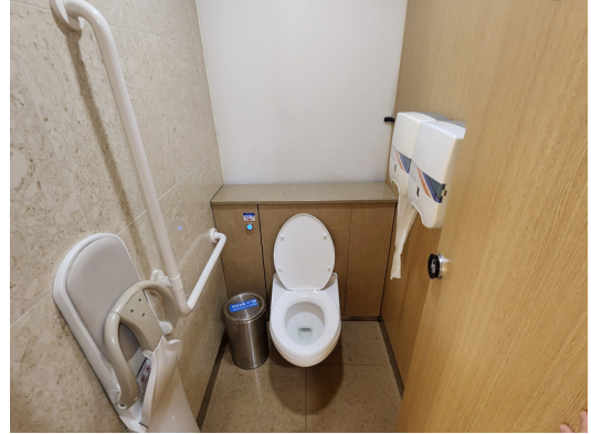
일반화장실 내에도 수평 및 수직손잡이를 설치할 수 있습니다. 바닥 부착형으로도 설치가 가능합니다.
