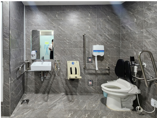
비상벨은 바닥면으로부터 0.6~0.9m 사이에 1개, 바닥면으로부터 0.2m 높이에 1개를 설치합니다.
