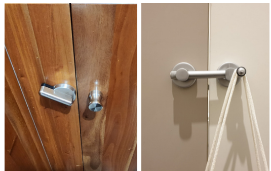
잠금장치를 반대로 설치하여 고리를 손잡이로 사용하거나 가방걸이로 사용할 수 있습니다.
