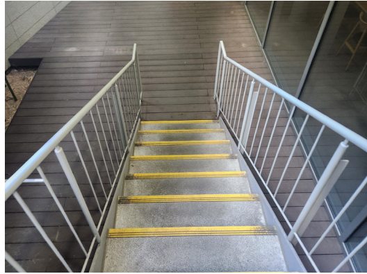
양측에 안전손잡이 설치와 계단 끝단 처리로 안전성 확보가 중요합니다.
