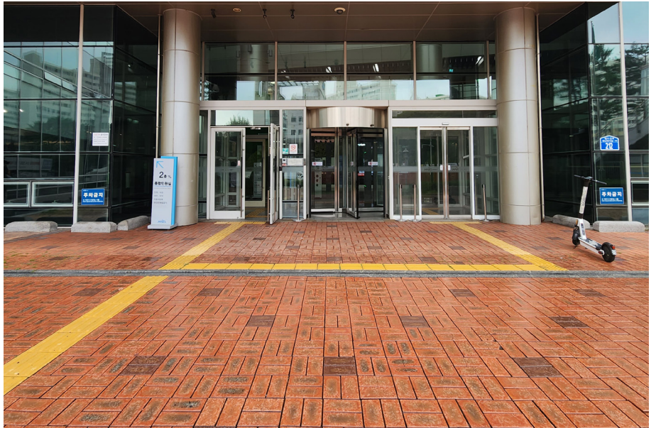
건축물의 접근로에는 시각장애인을 위한 유도블럭을 법규에 맞게 설치하며, 평탄하게 조성합니다.
