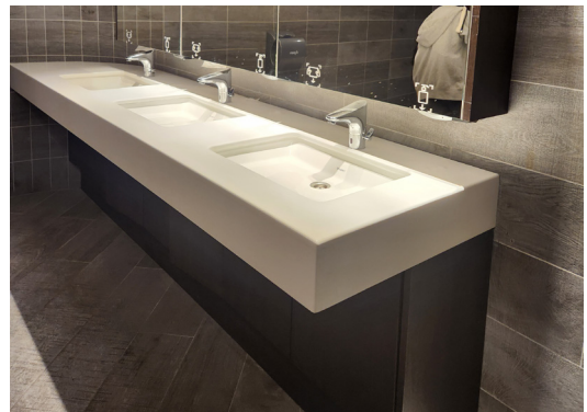
세면대는 얇은 깊이로 설치할 수 있으며, 하부는 공간을 비워 휠체어 접근이 가능하도록 합니다.
