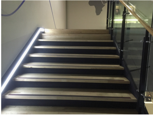
계단의 여부와 폭을 파악할 수 있도록 계단면을 비추는 조명을 설치합니다.
