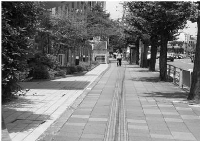
건축물 입구로 연결되는 유도블럭
